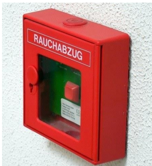
Рисунок 9 Ручной извещатель
