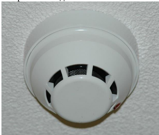
Рисунок 8 Пожарный датчик
